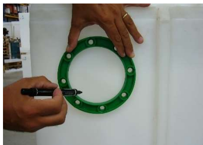
FIG.1) APPOGGIARE LA CONTROFLANGIA VERDE ALL'ESTERNO DEL POZZETTO
